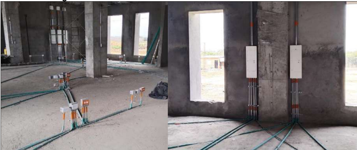
Estado de la tubería y puntos eléctricos en los bloques A y B una vez reinstalados.
