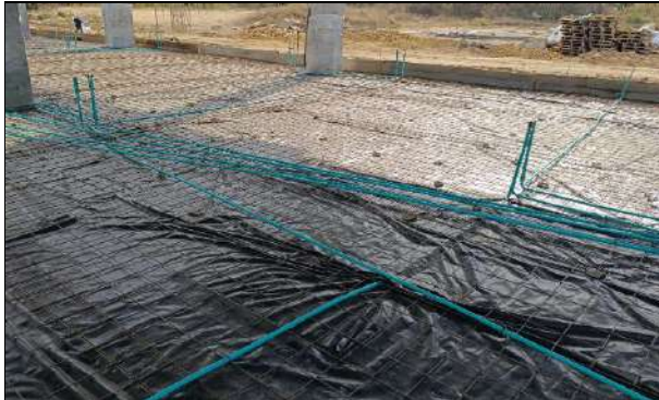
Evidencia de la tubería instalada antes de fundir la placa
