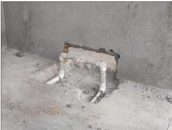
Demolicion de piso y muro para reubicacion d etuberia.
