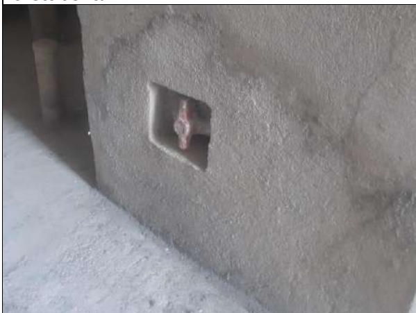
Resultado final de la reubicación de la tubería de registro en muro.
