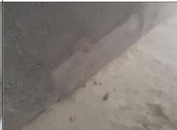
Resane de muro donde se reubico la tubería que se encontraba expuesta.
