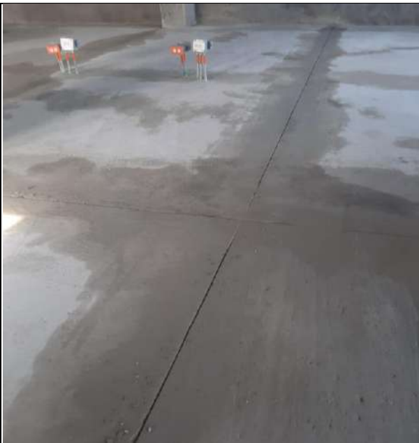
Resultado del corte en placa de contrapiso del bloque A.
