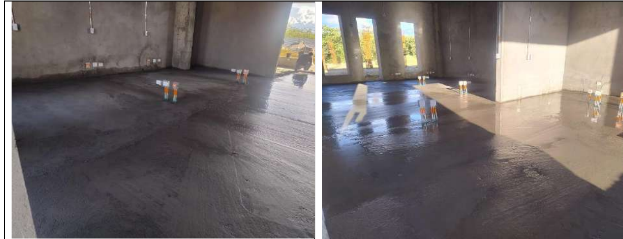
Alistado de piso terminado en area de los bloques A y gran parte del bloque B.
