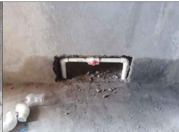
Reubicacion de tubo expuesto en muro.
