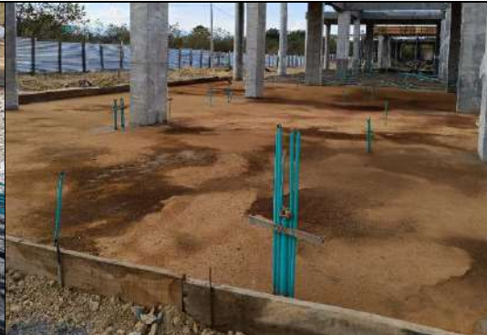
Evidencia de la tubería instalada con la placa fundida.
