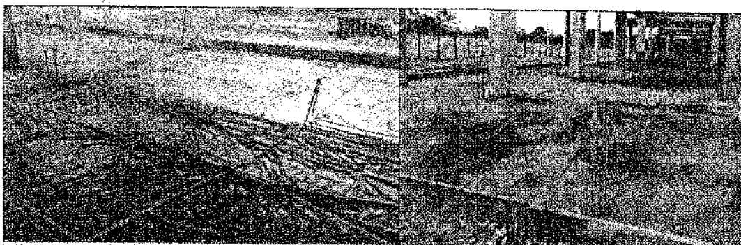
Evidencia de la tubería instalada con la placa fundida.
