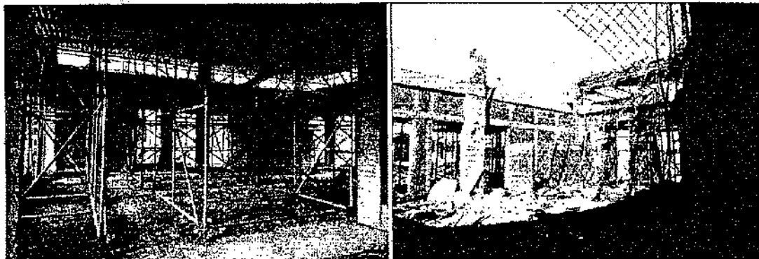
Estado en el que se recibió la placa y estado en el que se encontró.
