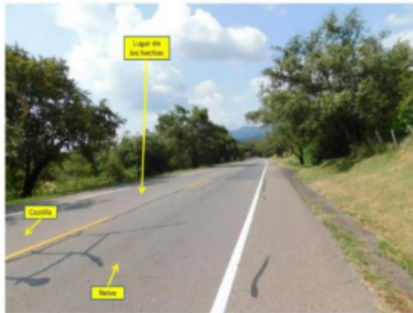
FOTOGRAFÍA No. 3 PANORÁMICA: En esta fotografía tomada por el equipo de IRS Vial en sentido Castilla – Neiva a la altura del km 58 + 700 m, se aprecian las características generales de la vía, en la cual se encuentra demarcación horizontal de línea amarilla segmentada y líneas de borde, sin señalización vertical; en este sentido se desplazaba el vehículo No. 1 (Camión).
