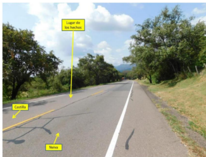
FOTOGRAFÍA No. 3 PANORÁMICA: En esta fotografía tomada por el equipo de IRS Vial en sentido Castilla – Neiva a la altura del km 58 + 700 m, se aprecian las características generales de la vía, en la cual se encuentra demarcación horizontal de línea amarilla segmentada y líneas de borde, sin señalización vertical; en este sentido se desplazaba el vehículo No. 1 (Camión).
