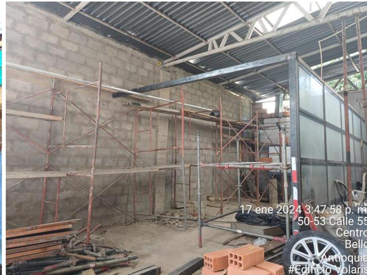
Construcción de columnas nuevas para dar apoyo a las cerchas de la cubierta, restauración y pintura de las cerchas afectadas.
