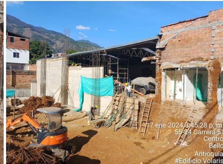
Fotografía de la construcción del muro nuevo en bloque según el diseño estructural
