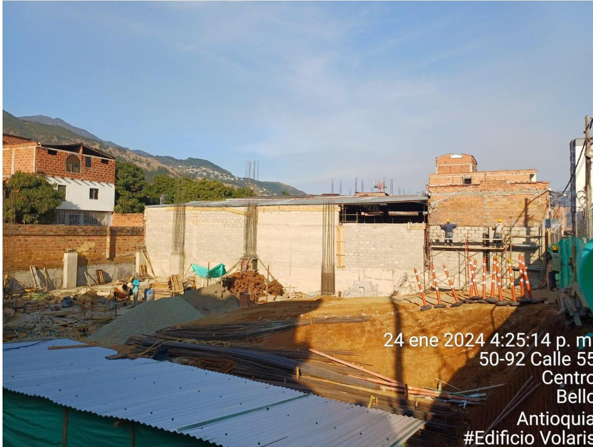
Vista desde el exterior del nuevo muro de encinte, muro en bloque dovelado y columnas nuevas para apoyo de la estructura de cubierta.
