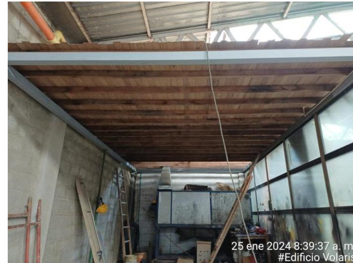
Reparación de la cabina de pintura, estructura metálica, pintura anticorrosiva y acabado, alfaras y tablilla en madera.
