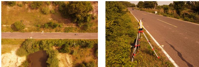
**Elaboración de plano topográfico:** Una vez recopilada la información topográfica de la vía, se elaborará el respectivo plano topográfico digital, el cual se comparará y cotejará con la información topográfica levantada por los agentes o policías de tránsito que conocieron del accidente.
