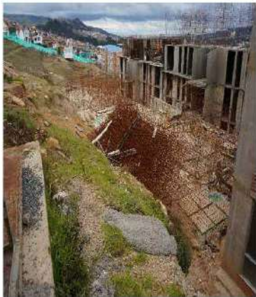
Comentarios: Vista general de los bloques 3 y 4 torre F, en construcción. Se observa el desarrollo de actividades en las viviendas a nivel de cimentación e inicio de estructuras en primer piso.
