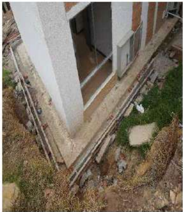
Comentarios: Vista de actividades exteriores de urbanismo pendientes en la torre G bloques 5, 6, 7 y 8. Se observa la instalación de formaleta para construcción de cunetas en concreto sobre las fachadas posteriores de la torre.
